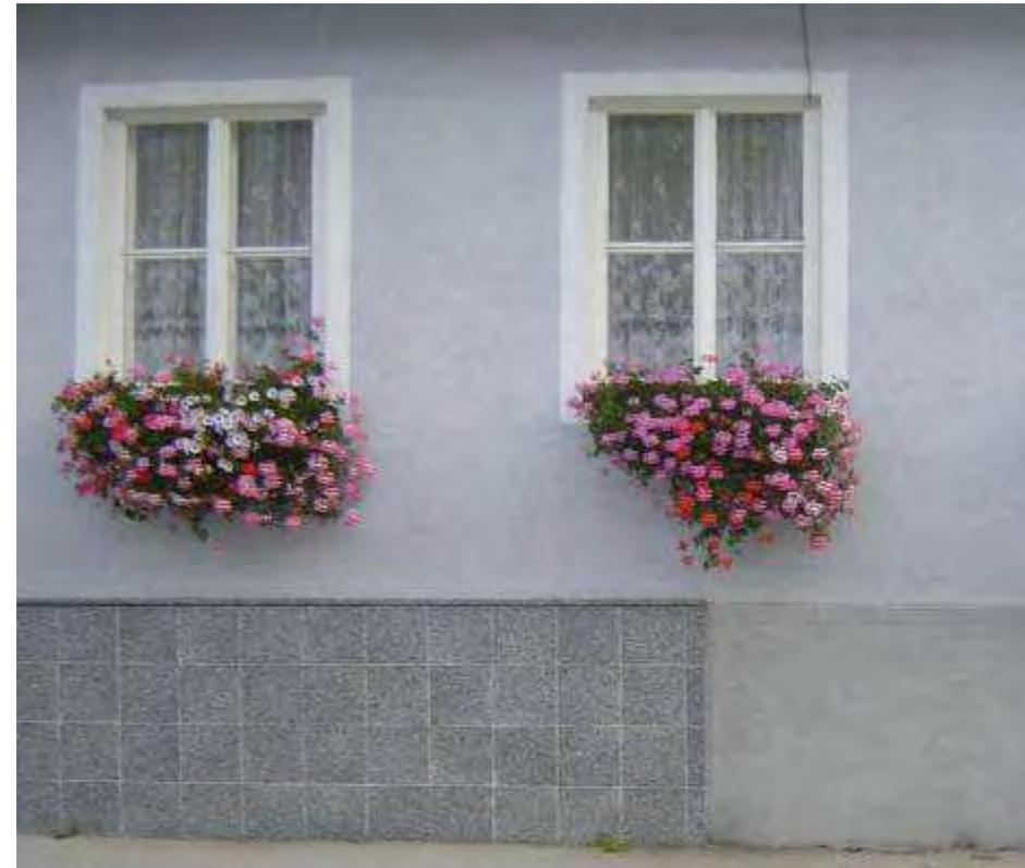
Durch betonierte oder verflieste Sockel kann keine Feuchtigkeit verdunsten – Feuchtigkeit steigt in die Höhe!
